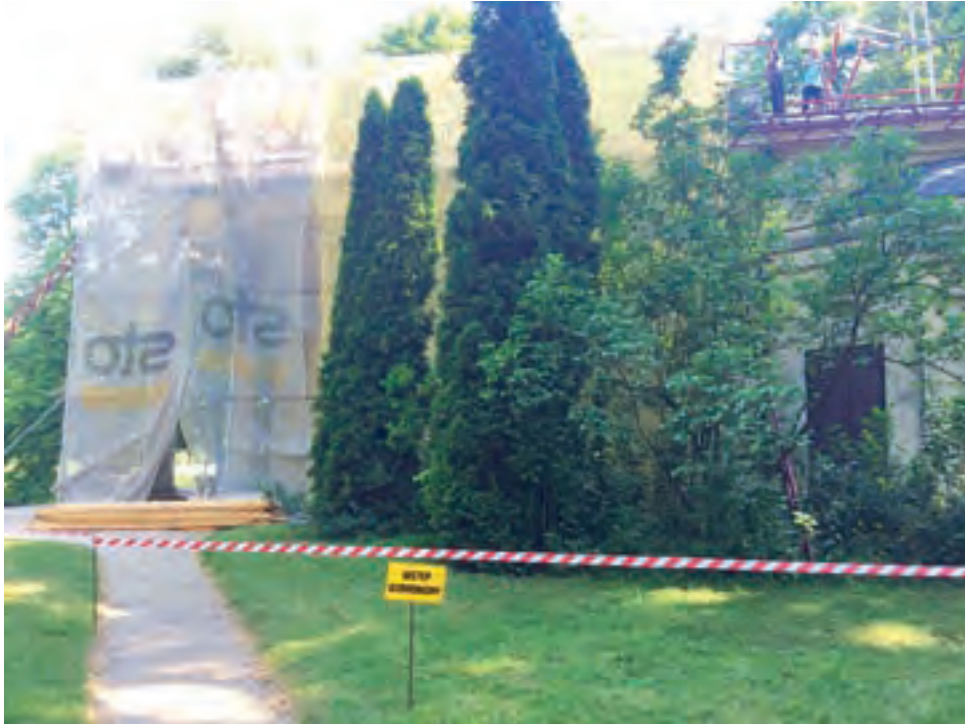
Prace remontowe Świątyni Diany właśnie się rozpoczęły. Widok od strony zewnętrznej.
