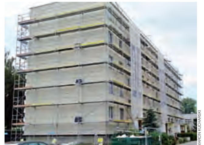
Kolejny blok na osiedlu Bratkowice jest docieplany i zyska nową elewację.
