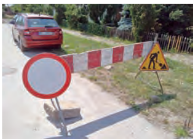
Prace na ul. Kopernika prowadzi łowicki PRID.
