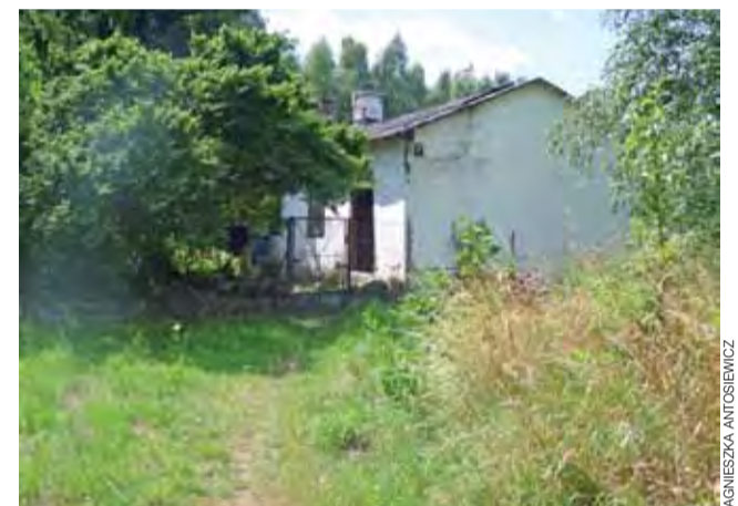
W szczególnie trudnej sytuacji jest jeden z mieszkańców, który po likwidacji najbliższych przejazdów zostanie odcięty od reszty wsi i pozbawiony jakiegokolwiek drogi do domu.
