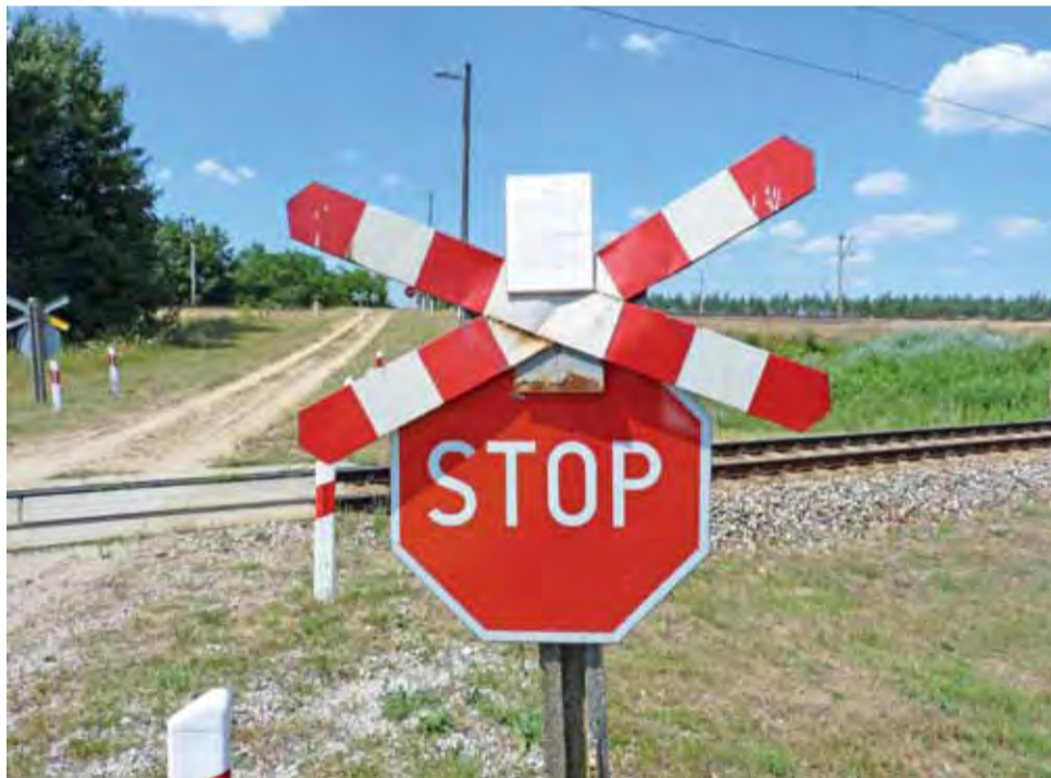
Zamknięcie tego przejazdu odetnie drogę do domu jednemu z mieszkańców, rolnikom zaś dojazd do pól.
