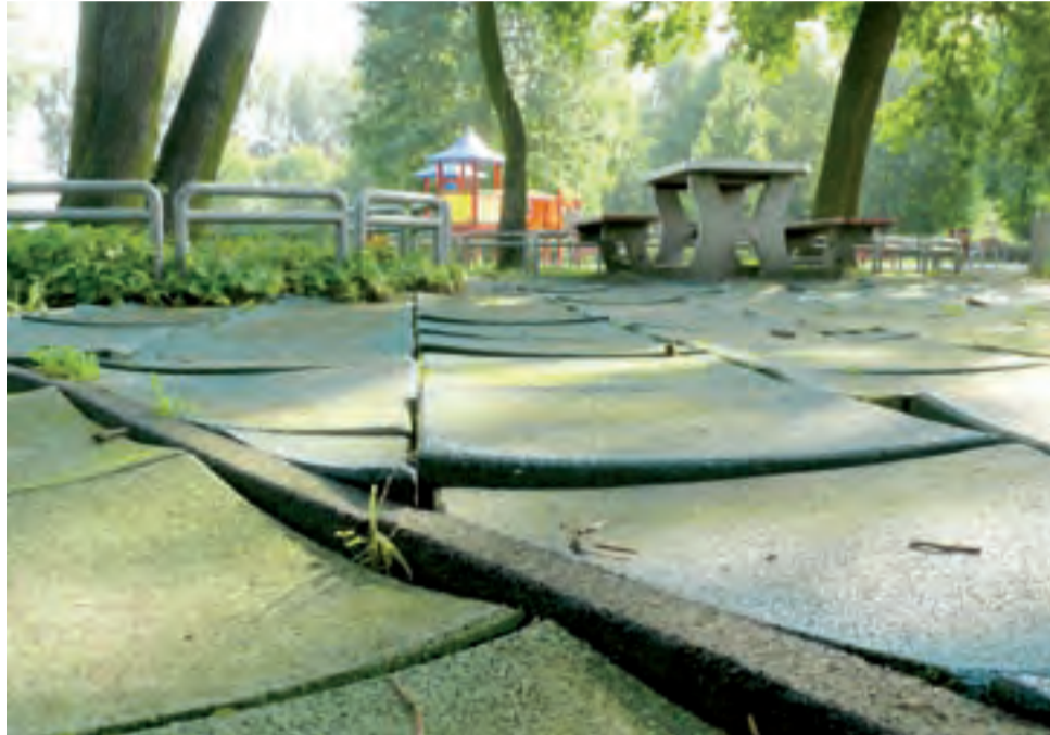
Nierówna nawierzchnia na placu zabaw dla najmłodszych dzieci w parku Błonie. W ramach tegorocznych prac 88 m 2 zostanie wymienionych, reszta ma być przełożona.
