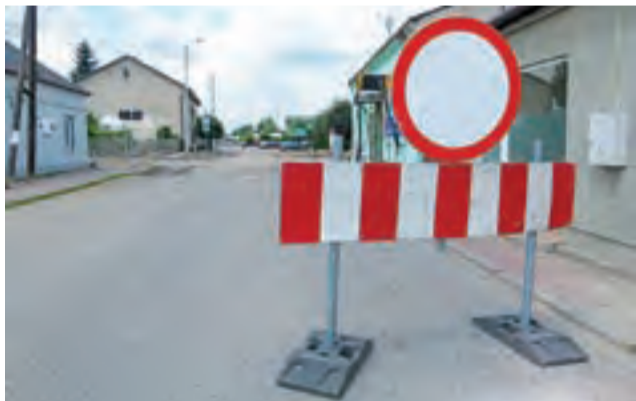
Zakaz obowiązuje. Znak i bariera zabraniająca przejazdu przez przebudowywaną 703-kę od strony ulicy Parzew w Bielawach.
