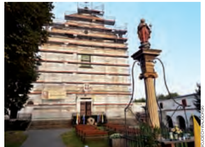
W sanktuarium trwa remont elewacji, ale zasadniczo nie przeszkadza to w odprawianiu mszy.
