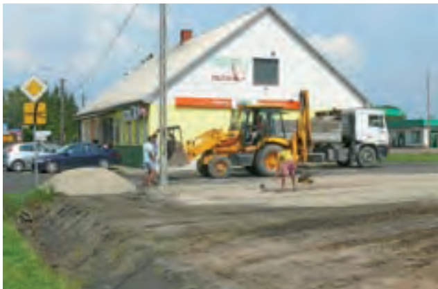
Budowa parkingu przy sklepie ABC w Bednarach – stan z ubiegłego tygodnia.
