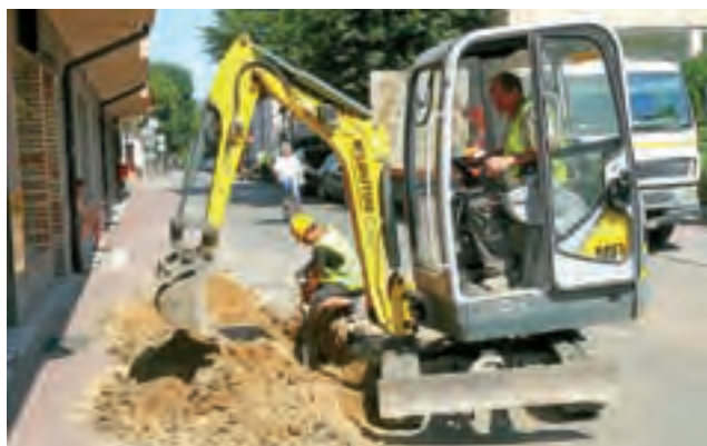
Prace na ul. Browarnej przy budowie nowego odcinka sieci gazu ziemnego.
