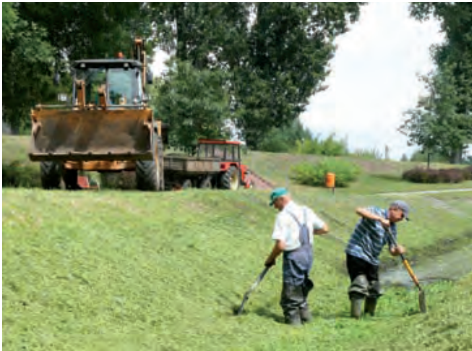
Prace przy odmulaniu dna kanału Malinówka w parku Błonie.
