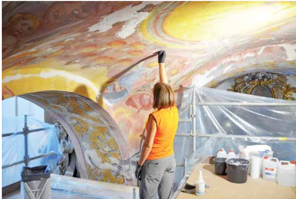
Prace konserwacyjne prowadzone są obecnie w II i III przęsle nawy zachodniej.
