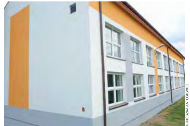
Sala gimnastyczna w Szkole Podstawowej w Łącuszewie zyskała nową elewację.
