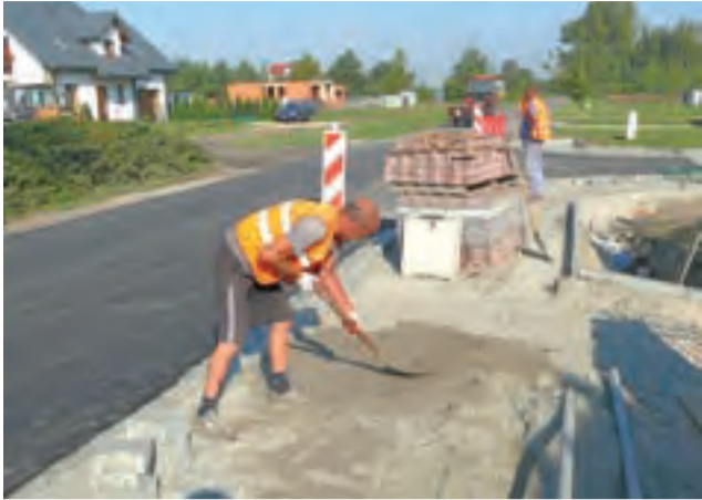
Ostatnie prace na ulicy Sokołowskiej w Bolimowie. 21 i 22 września układano ostatnią część chodnika.
