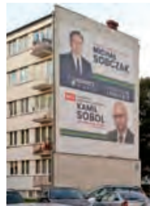
Plakaty wiszą na niedocieplonej elewacji za zgodą ŁSM i nie za darmo.
