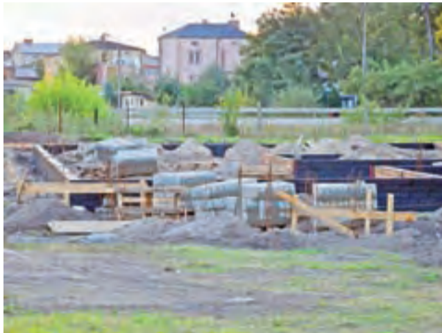
Na placu budowy przy cmentarzu już widać zarys budynków.
