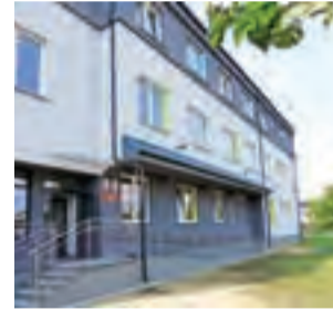
Budynek MOS w Kiernozi.
