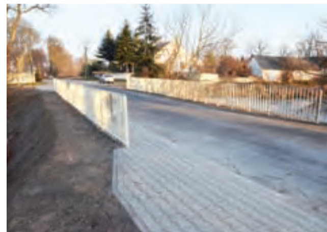
Przepust na ulicy Farnej po remoncie wygląda jak nowy i – co najważniejsze – stał się bezpieczny dla użytkowników.
