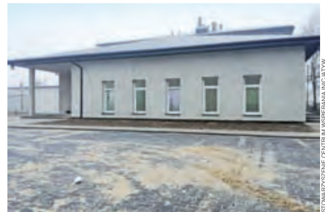
Dobudowana sala ogólna ŚDS w Woli Zbrożkowej. Sala, wzniesiona w 2016 r., została teraz wykończona.
