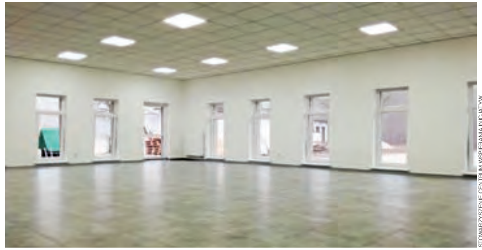
Dobudowana sala ogólna. Została ona wykończona w ramach zrealizowanego w tym roku projektu.
