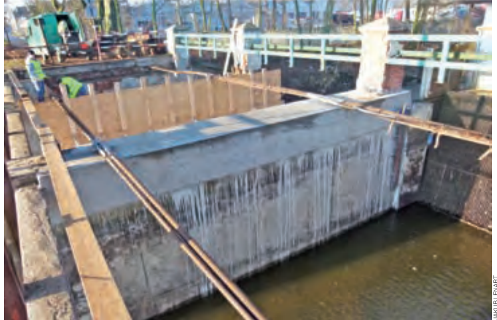
Choć w kalendarzu styczeń, prace na jazu trwają.
