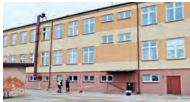
Skok z wysoka. Pierwsze piętro szkoły w Dmosinie, ze względu na wysokie podpiwniczenie gospodarcze i wysoki parter, znajduje się na takiej wysokości, na jakiej w innych budynkach są wyższe kondygnacje.
