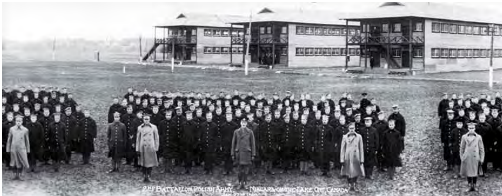
Obóz dla ochotników do Armii Polskiej we Francji. Żołnierze na tle baraków mieszkalnych. Niagara (Kanada), 27 stycznia 1919 r.
