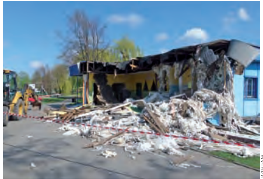
Budynek wypożyczalni w trakcie rozbiórki. Wkrótce zniknie z krajobrazu Głowna
