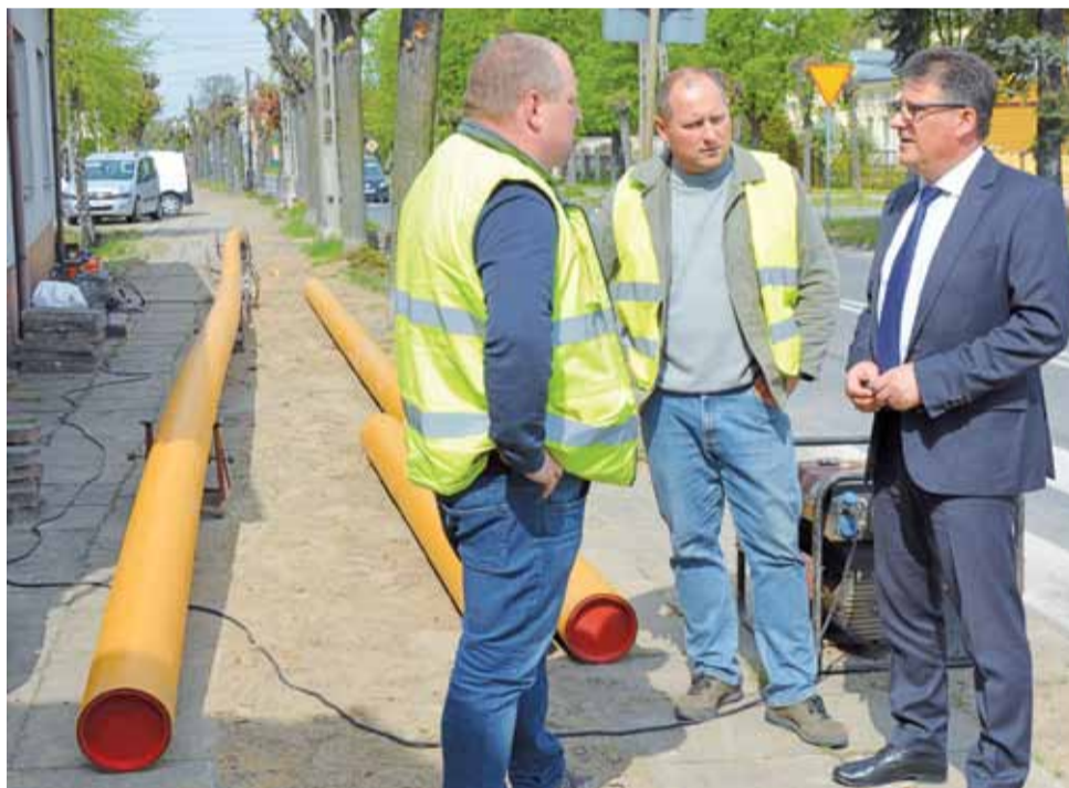
Najpierw gazociąg, potem chodnik. Wojciech Brzeski na terenie budowy na ul. Targowej w Głownie.
