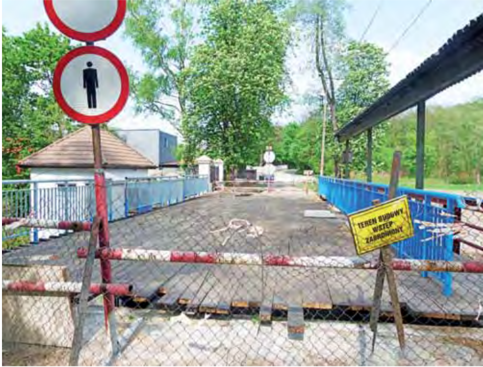
Jaz (stan na 30 kwietnia) niedługo przestanie być terenem budowy.
