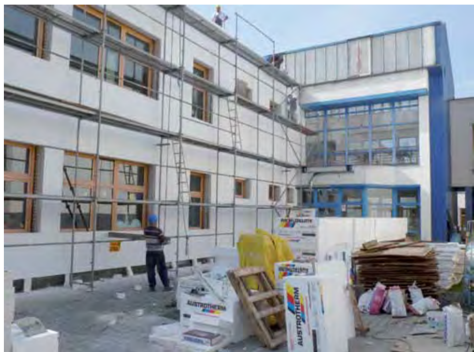
Prace przy Szkole Podstawowej nr 2 toczą się w szybkim tempie.
