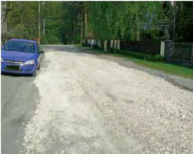
Po naprawie. Gruntowa nawierzchnia ul. 18 Stycznia została wyrównana i uzupełniona tłuczniem, stan na 23 kwietnia.
