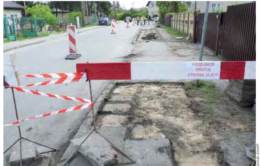
Rozpoczęła się już budowa chodnika przy ul. Słowackiego w Głownie, na odcinku od ul. Kopernika do ul. Wojska Polskiego. Na czas prowadzenia robót ruch pieszki prowadzony jest jedną stroną. Za wykonanie tej inwestycji miasto ma zapłacić firmie Tom-Bud z Domaniewic 109.000 zł brutto. Chodnik powinien być gotowy mniej więcej w ciągu miesiąca. kl
