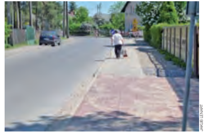
Część chodnika przy ul. Słowackiego jest już gotowa.
