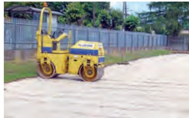
Wyrównywanie terenu. Stan prac nad przebudową boiska na 25 maja.
