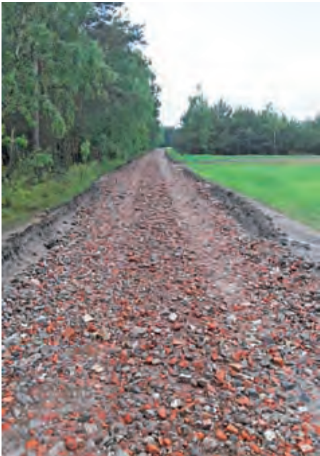
Droga na tzw. Przydatkach w trakcie remontu. Stan na 23 maja.
