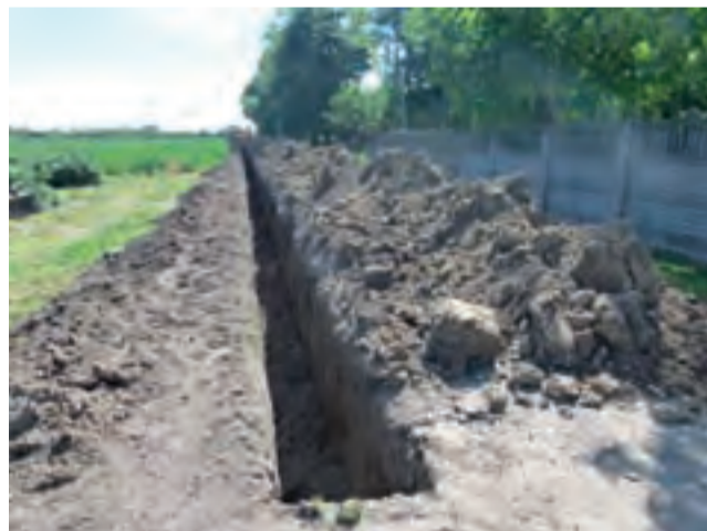
Budowa wodociągu w Konarzewie. Stan prac na 24 maja.
