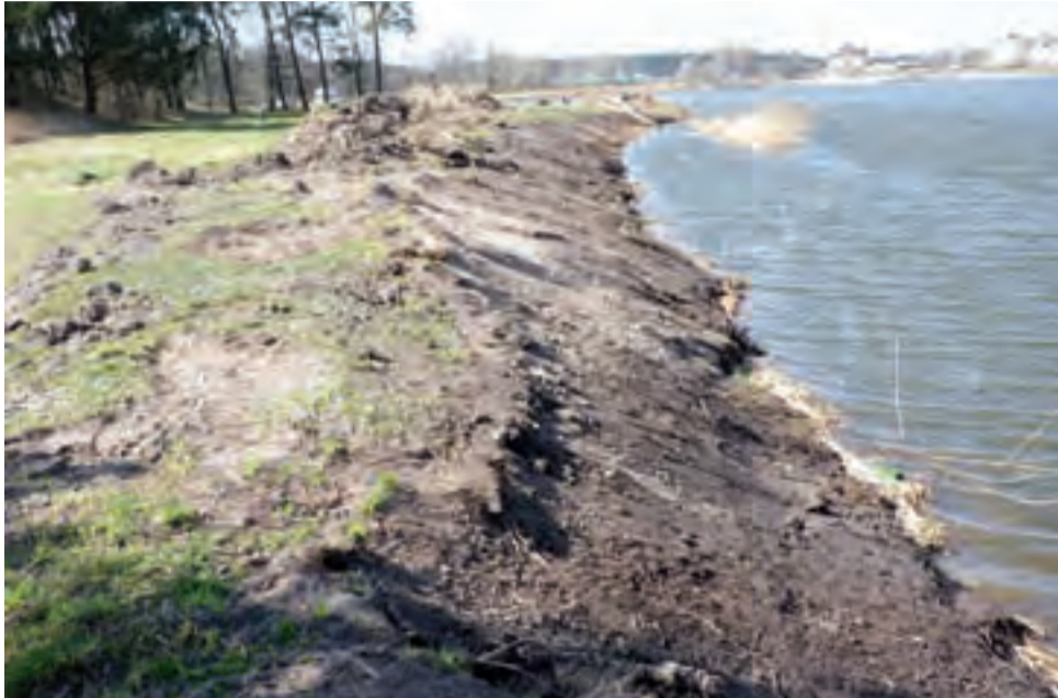
Kwietniowe prace ziemne nad zalewem od strony drogi krajowej nr 14. Od tamtej pory w kwestii budowy wakeparku w Głownie niewiele się zmieniło, bo inwestor borykał się z problemami natury formalnej.
