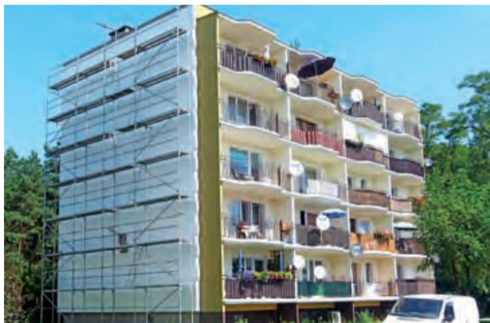
Prace dociepleniowe. Osiedle W. Sikorskiego w Głownie, 2 sierpnia.
