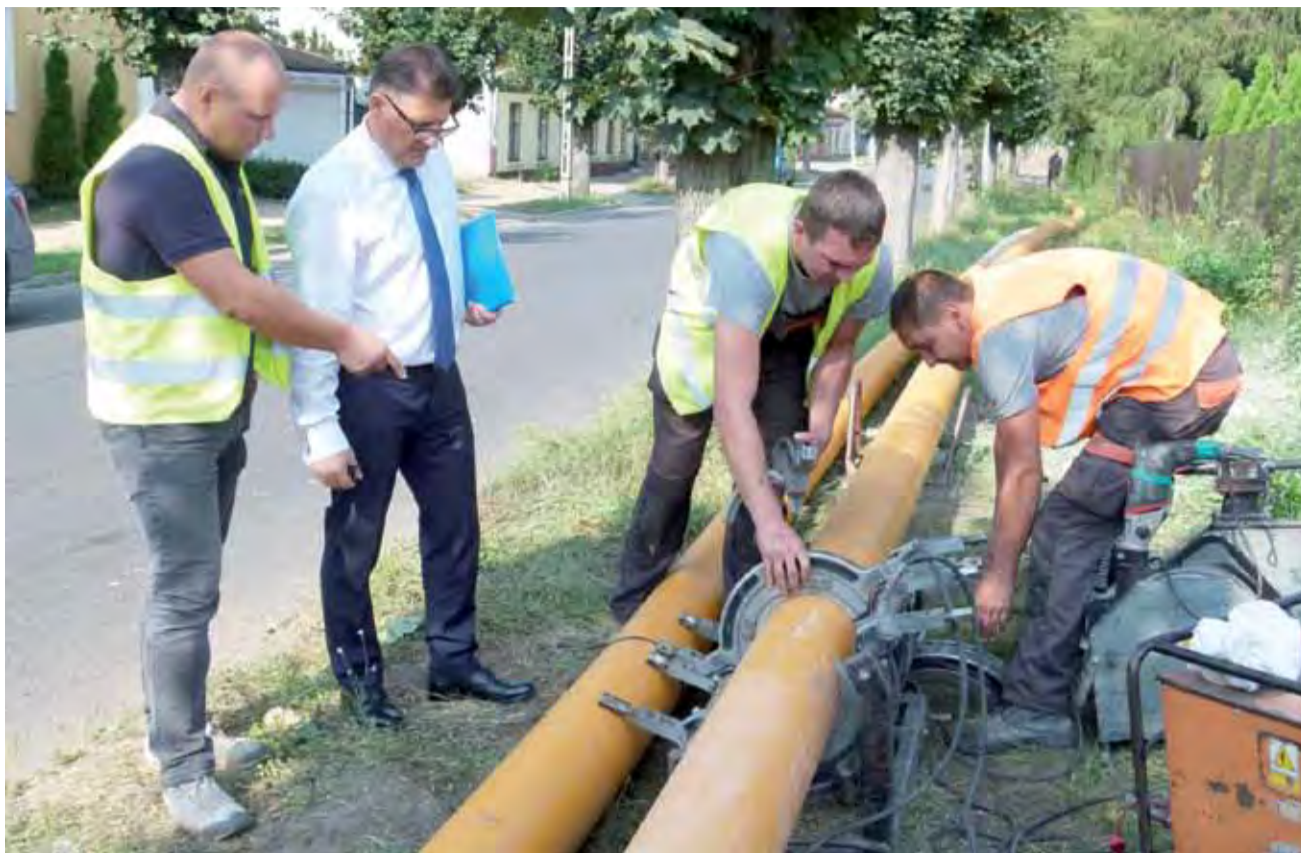
Łączenie rur. Pracom na budowie gazociągu w pasie drogi powiatowej (ul. Targowej w Głownie) przygląda się członek Zarządu Powiatu Zgierskiego Wojciech Brzeski.
