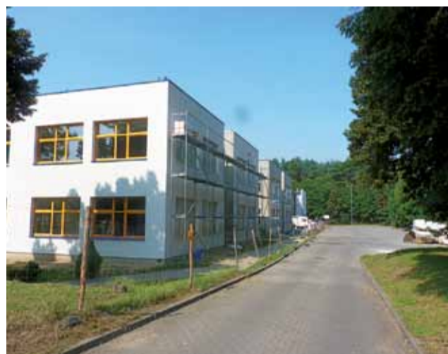
W niedzielę, 2 września, na terenie SP nr 2 ciągle jeszcze stały rusztowania.
