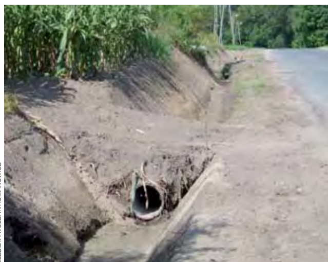
Efekt prac odwodnieniowych przy powiatówce w Ziewanicach.
