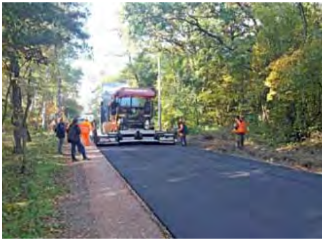
Prace w toku. Budowa drogi w czwartek, 11 października.
