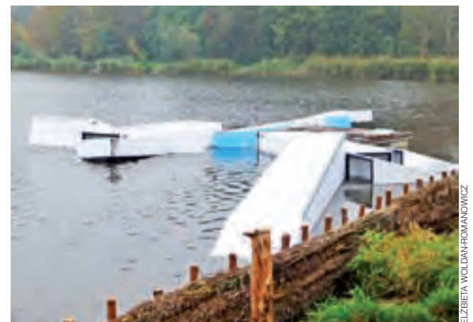
Elementy, z których powstaną przeszkody dla wakeboardzistów. Budowa wakeparku w Głownie, stan na 19 października.
