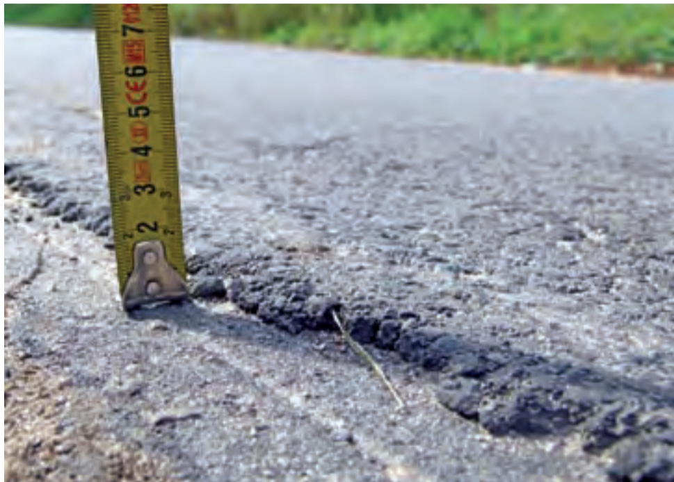
Nie za cienki ten dywanik? Tak wygląda nakładka położona w 2017 r. na starym asfalcie w Antoniewie, mierzona miarką.
