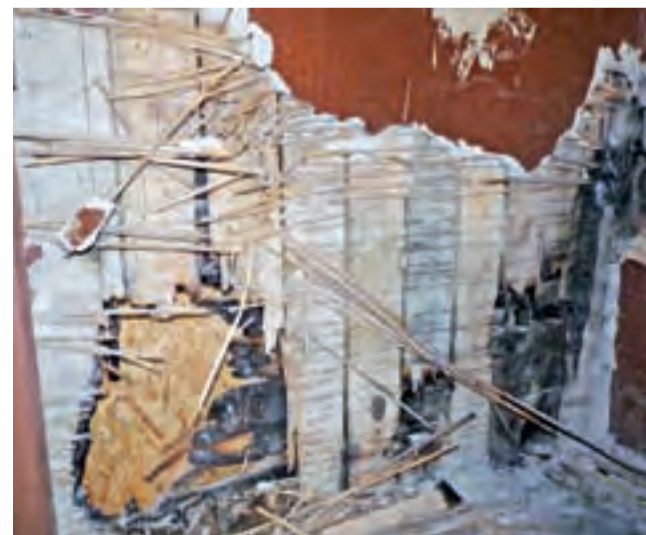
W celu ugaszenia ognia w budynku trzeba było rozebrać część ściany jednego z lokali.
