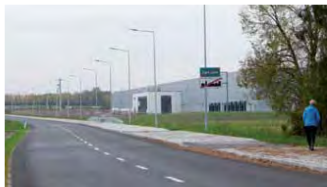
Droga do magazynów w Smolicach to efekt porozumienia gminy z prywatnym inwestorem.
