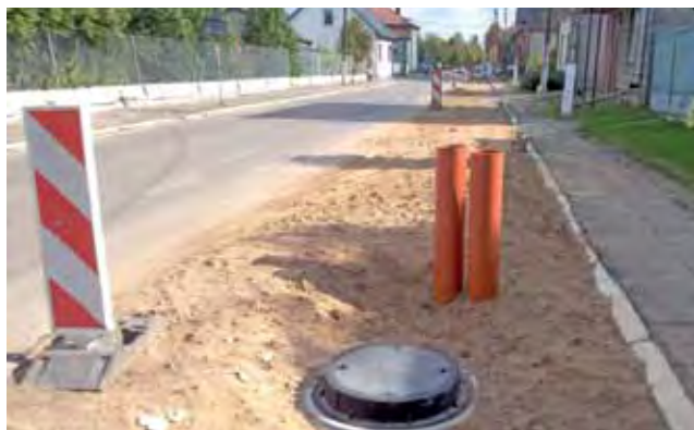
Ulica Żychlińska – budowa kanalizacji została prawie zakończona.
