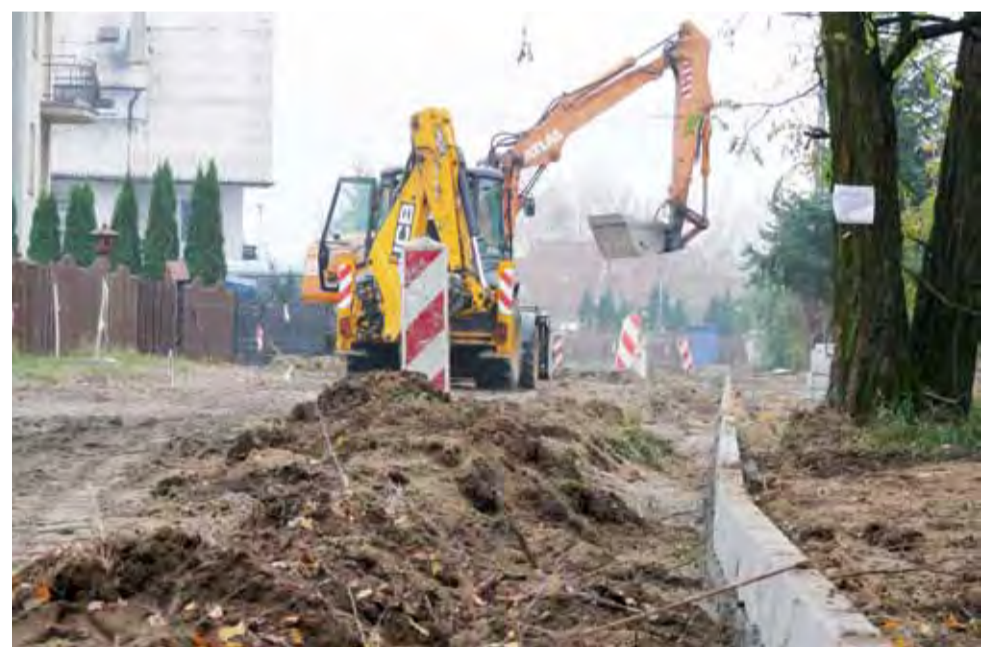
Budowa nawierzchni ul. Moniuszki na os. Górki rozpoczęła się od ułożenia krawężnika.
