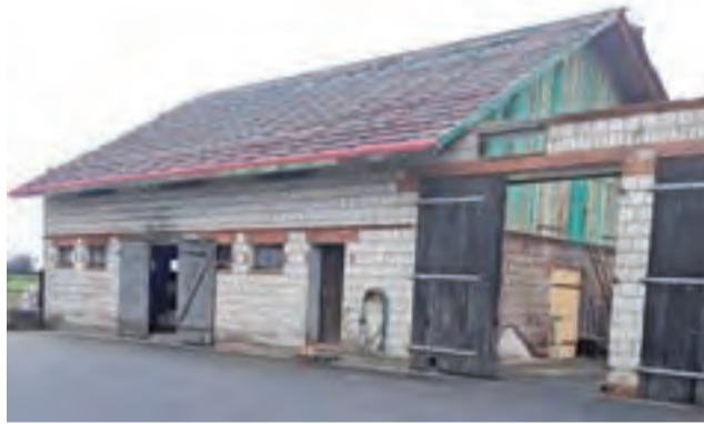
Obora już pod nowym dachem. Bydło wróciło do gospodarzy, ale spaloną stodołę (fragment widoczny po prawej) trzeba rozebrać.
