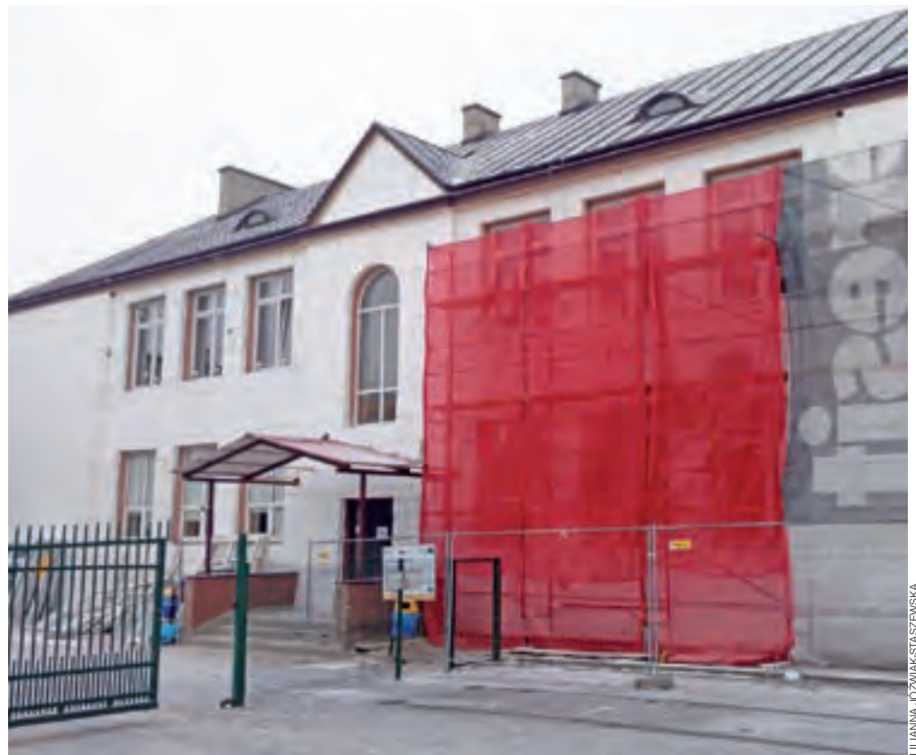
ijs Termomodernizacja objęła w pierwszej kolejności tę część szkoły, którą stanowi budynek gimnazjum.
