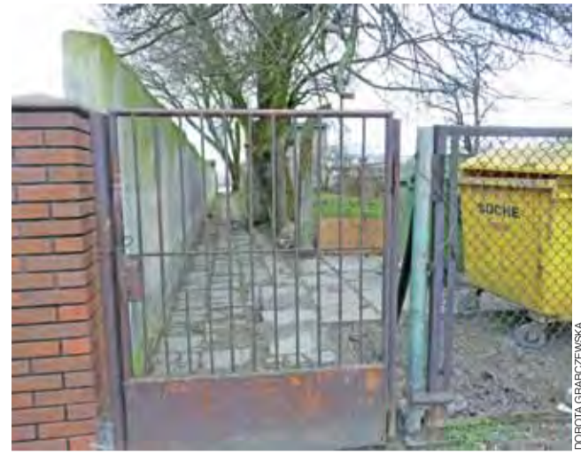
Dawne wejście na targowicę jest od lat nieczynne. Zamknięte furtką. Docelowo drzewa mają być wycięte, a wejście poszerzone. Nie zapadła tylko decyzja, czy budynek na końcu będzie rozebrany, czy ominięty łukiem.
