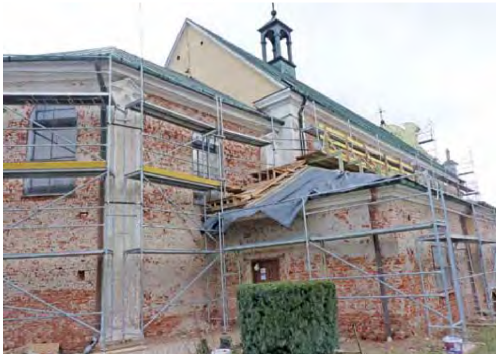
Dach na przybudówce zakrystii zabezpieczono warstwą styropianu, płytą i folią oraz zbudowano drewniany podest, na którym pracownicy mogą bezpiecznie pracować.
