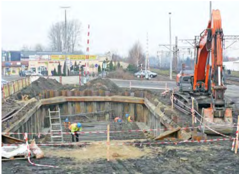
Przygotowywanie zbrojenia fundamentu trzeciej podpory estakady, na której oprze się też stalowa konstrukcja wiaduku.
