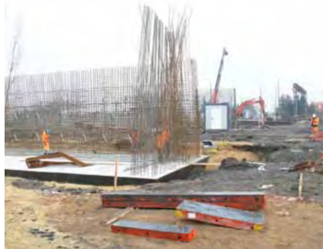
Plac budowy estakady. Na pierwszym planie zbrojenie pierwszej podpory, za nią drugiej. Trzecia powstanie tu, gdzie widać ramię koparki.
