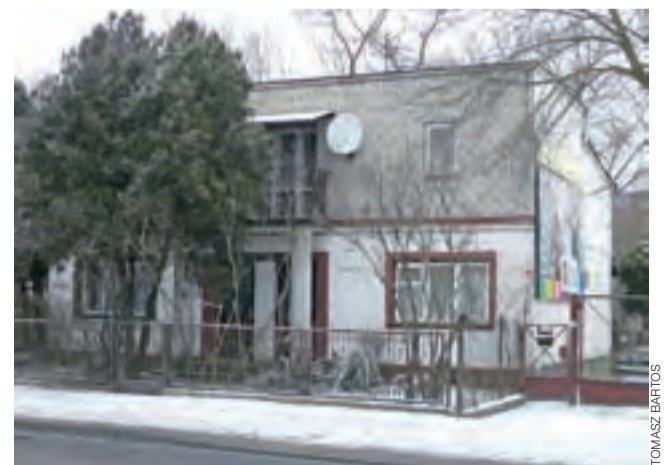
Budynek, który zostanie rozebrany pod rondo w ul. Bolimowskiej.
