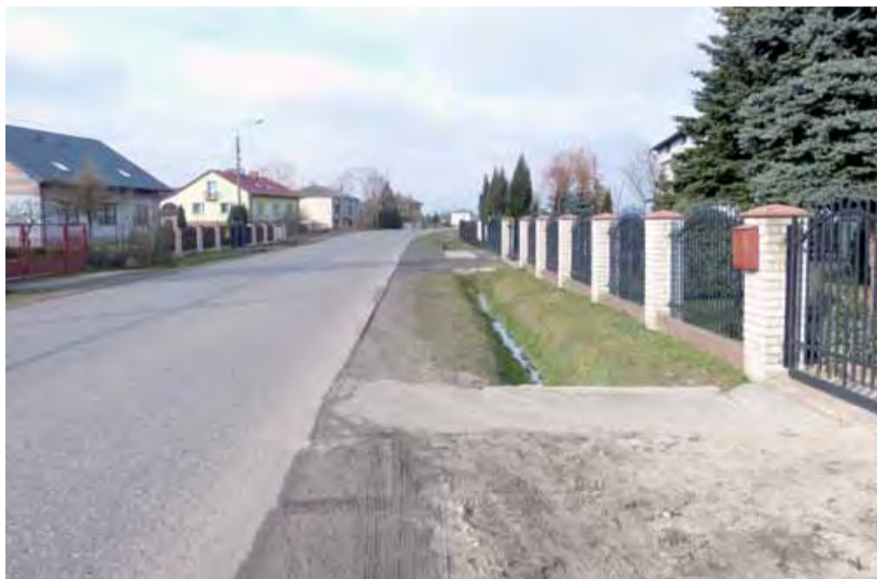
Julianów jest gęsto zabudowaną miejscowością. Droga powiatowa biegnąca przez wieś nie ma bezpiecznych poboczy. Mieszkańcy oczekują, że powstanie tu chodnik.
