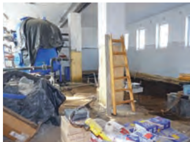
Tak wygląda w środku modernizowana Stacja Uzdatniania Wody w Głuchowie, której budowa miała zakończyć się do 28 lutego.
