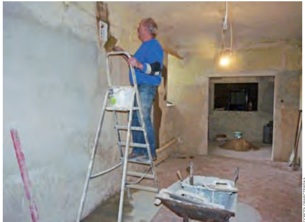
Kompleksowy remont w drugiej szatni ZS nr 1 trwa. Prace wykonuje konserwator Sławomir Gajda.
