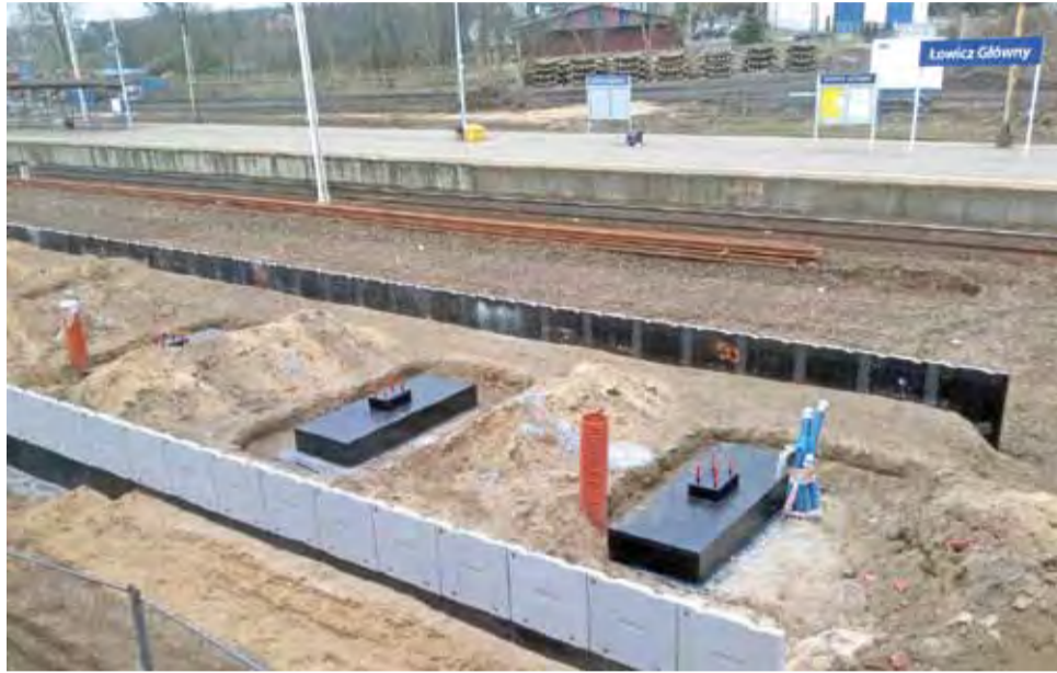
Peron pierwszy na dworcu Łowicz Główny jeszcze nie jest gotowy, aktualnie budowane są fundamenty, na których będzie opierać się zadaszenie.
