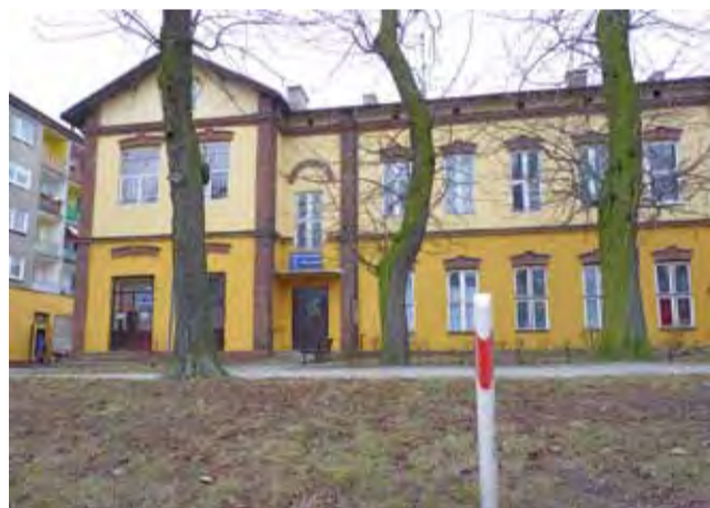
W tym roku Spółdzielnia Mieszkaniowa Wspólny Dom planuje podłączenie do miejskiego ciepła budynku, w którym znajduje się siedziba spółdzielni.
