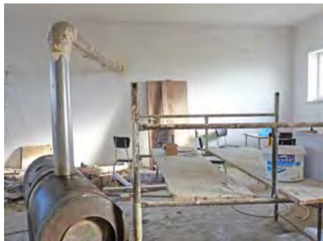
Duża sala w świetlicy w Czesławowie to wciąż duży plac budowy. Mig-My wstawiła specjalną dużą nagrzewnicę, by wysuszyć ściany budynku.
