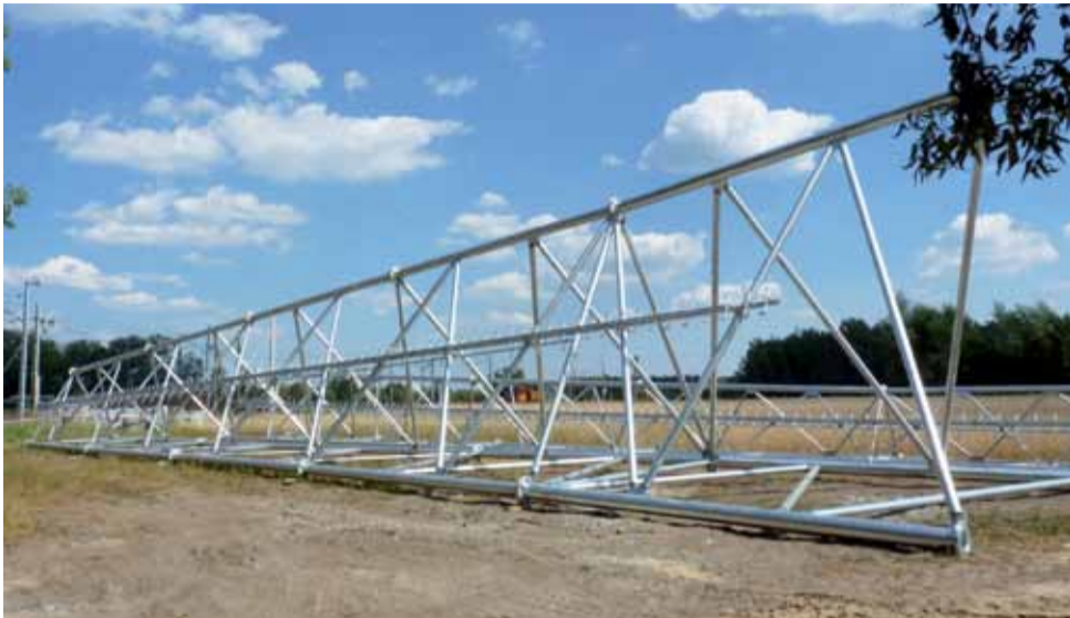
Na jedną z działek w Zielkowicach została przywieziona konstrukcja masztu sieci komórkowej Play. Plan miejscowy nie przewiduje realizacji w tym miejscu tego rodzaju inwestycji.
