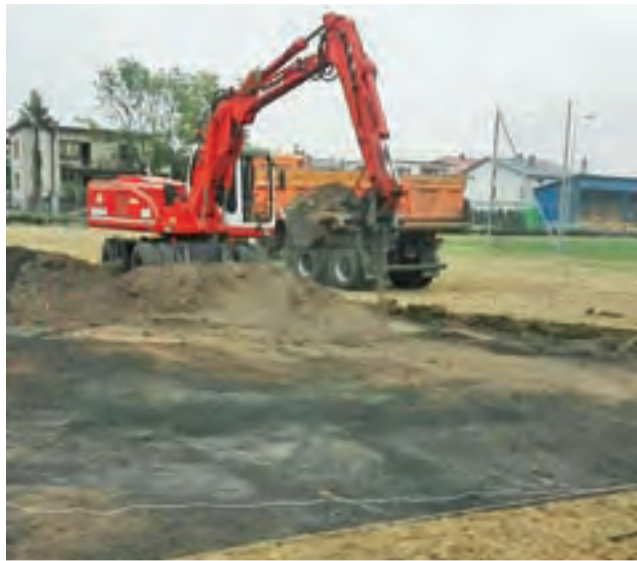
Na stadionie miejskim w Żychlinie trwają intensywne prace budowlane.
