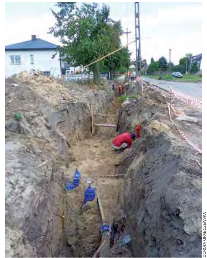
Pracownicy firmy Elvis zrobili pierwszy etap wodociągu.
