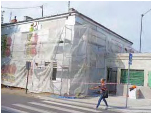
Kamienica komunalna stojąca na rogu ulic Narutowicza i 29 Listopada, obok zmodernizowanego ronda, jest docieplana. Wkrótce będzie też mieć nową elewację.
