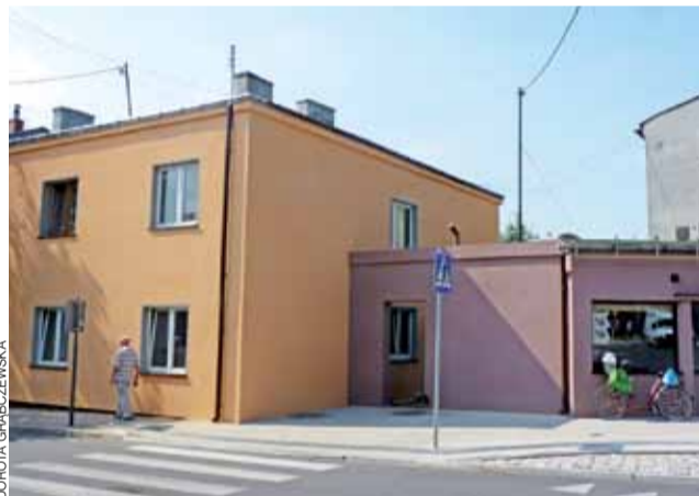
Budynek w centrum Żychlina, przy rondzie, ma nową elewację. Trwa układanie dachu na parterowej przybudówce.
