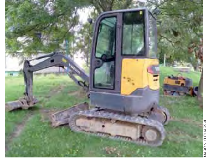
– Tak wygląda park maszynowy wykonawcy robót – żartuje pracownik oczyszczalni.
