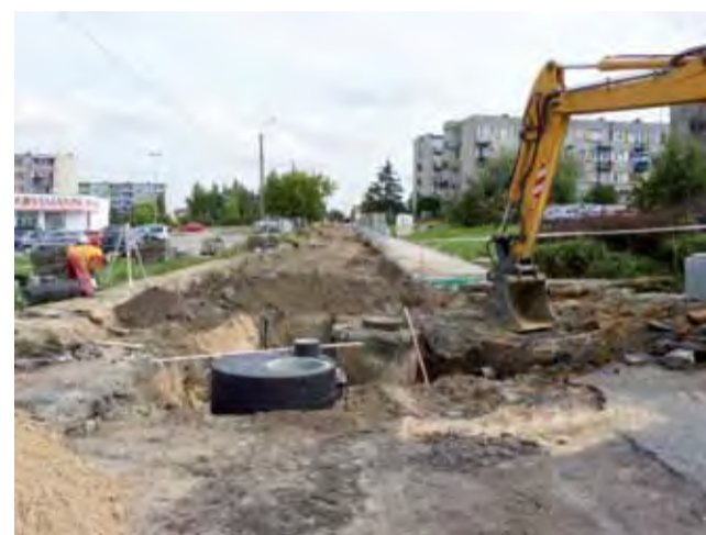
Ulica Żeromskiego wciąż jest wielkim placem budowy. Do 3 września nie uda się położyć asfaltu na części modernizowanej ulicy, do szkoły.
