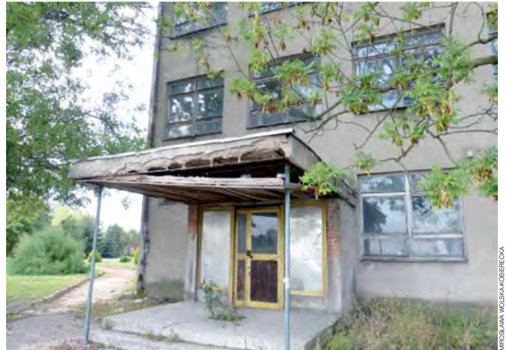
Daszek nad wejściem do dawnego biurowca rozwarstwił się i w każdej chwili może runąć.
