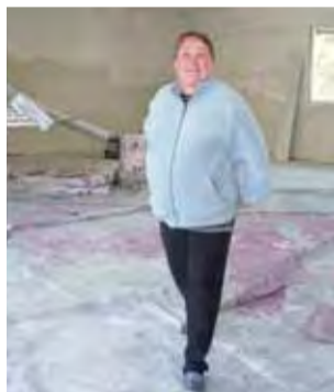
Agnieszka Zgieb, sołtys Podczachach i radna nadzoruje prace przy remoncie świetlicy.
