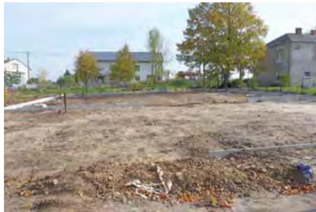
Prace przy budowie placu zabaw w Podczachach, obok świetlicy są w powijkach, choć zakładano, że jego budowa zakończy się 24 września.
