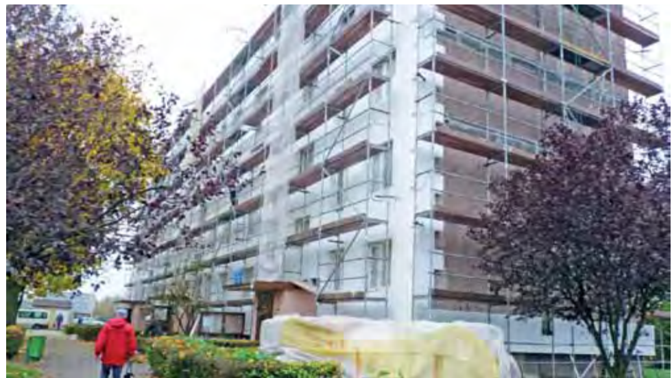
Termomodernizacja bloków Łąkowa 5 i 7 jest na półmetku.
