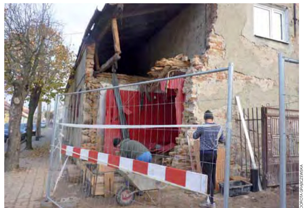
Rozpoczęto prace zabezpieczające budynek przy ul. Narutowicza 35.
