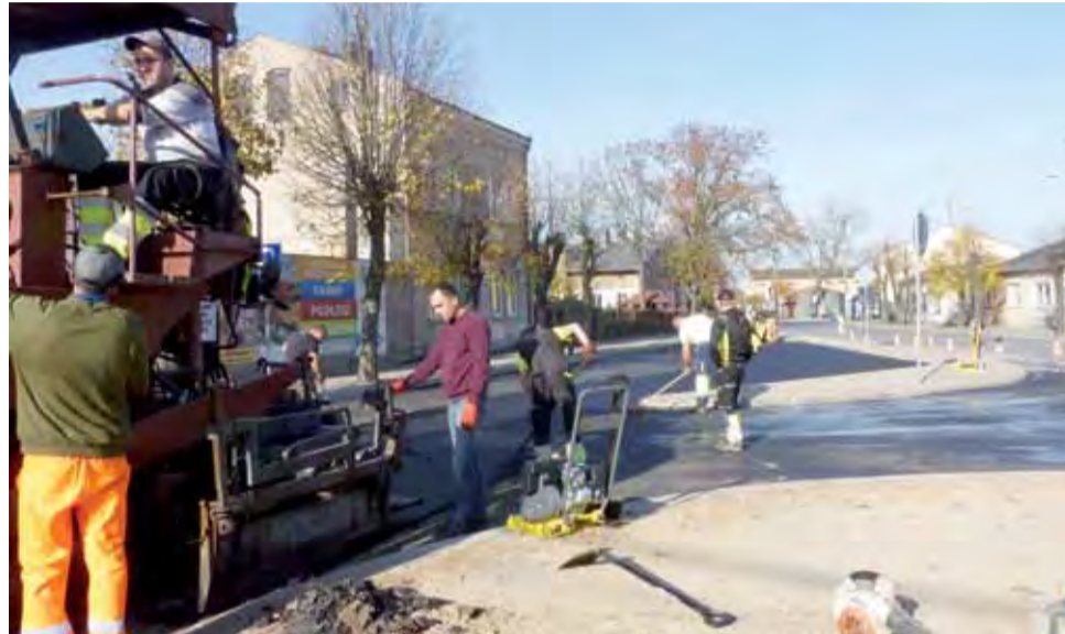
Fragment przebudowywanego skrzyżowania zalewano masą bitumiczną 2 listopada.
