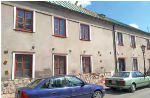
Na zewnątrz budynku widać końcówki stalowych ściągnięć, które zabezpieczają teraz jego nośne ściany.
