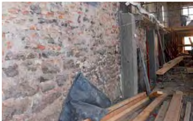
W ścianie budynku widoczne są kamienie narzutowe, cegły i ruda darniowa. To charakterystyczne dla połowy XIX wieku materiały budowlane.
