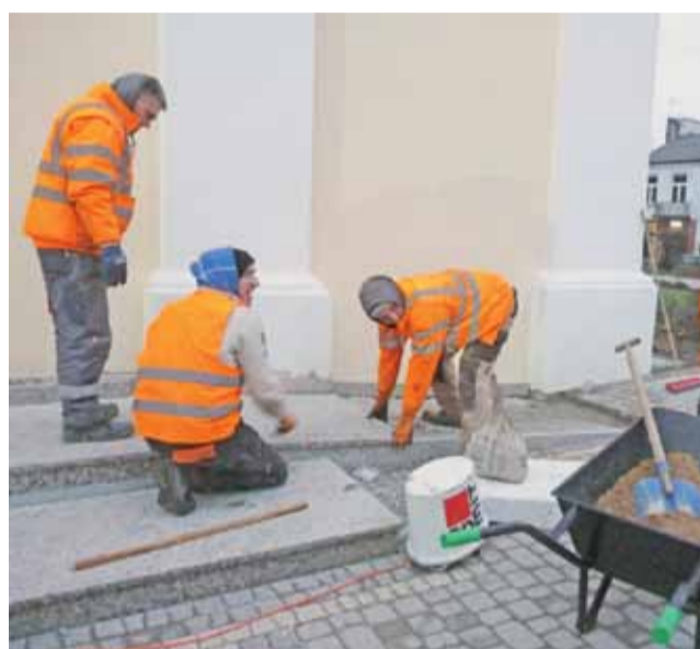
W czwartek po południu pracownicy firmy Elvis z Żychlina poprawiali schody do kościoła w Żychlinie. Teraz robili podjazd dla osób niepełnosprawnych.
