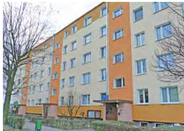
Termomodernizacja dwóch bloków w Spółdzielni Mieszkaniowej.
