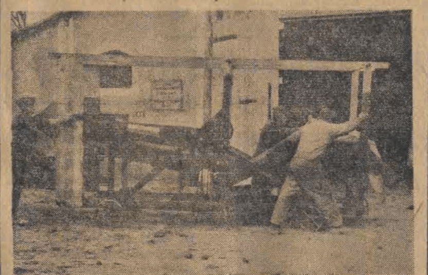
FGR Kobierzycy zyskało nowo wyremontowaną halę maszyn rolniczych. Maszyny rolnicze, oczyszczone i zabezpieczone przed wpływami atmosferycznymi, czekają na wiosenne prace w polu
