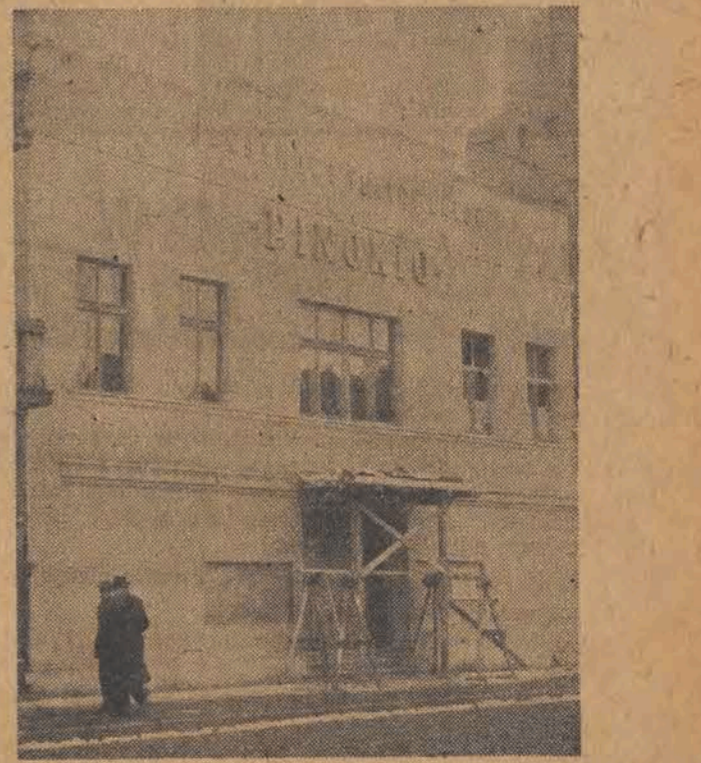
Przy ul. Kopernika w pobliżu Gdańskiej remontowany jest budynek, w którym znajdzie pomieszczenie nowoczesny teatr dla dzieci.
