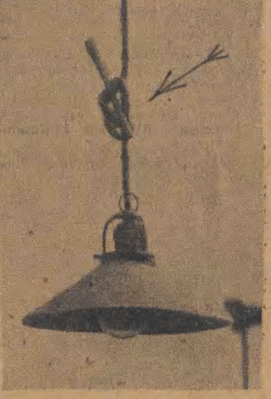
Przewodnik zawiązany w węzeł łatwo może zlamać się i iskrzyć. Warstwa pyłu bawełnianego łatwo może stać się żarzącym. PRZE WADNIKÓW NIE WOLNO WIAZAĆ — KURZ NALEŻY CZĘŚCIEJ USUWAĆ!
