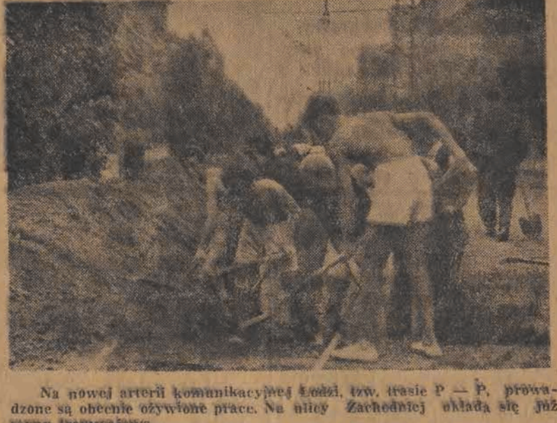
Na nowej arterii komunikacyjnej Łodzi, tzw. trasie P — P, prowadzone są obecnie ożywione prace. Na ulicy Zachodniej ułożona jest już szyna tramwajowa.
