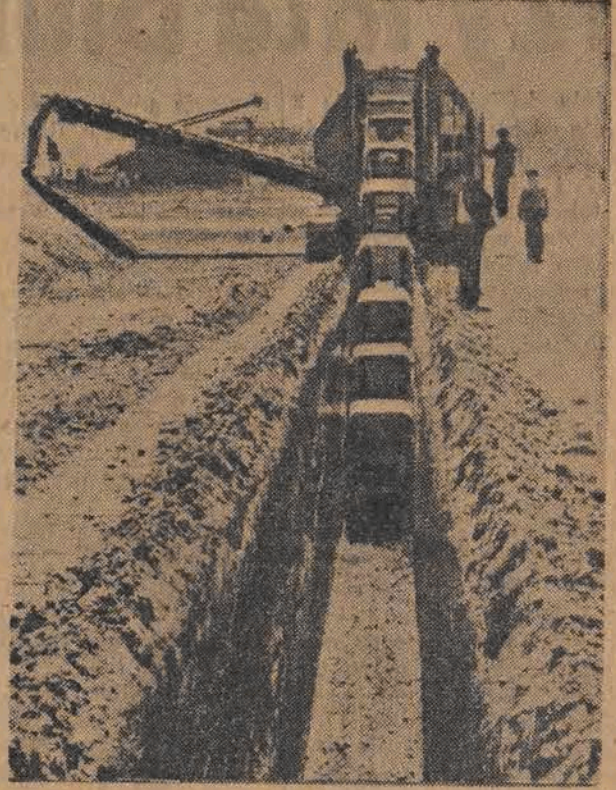
Stosownie do uchwały Rady Ministrów ZSRR — o nowoczesnych sposobach nawadniania obszarów pustynnych — uruchomiono już tysiące maszyn — kopiących rowy nawadniające (magistrale wodne). Na ilustracji widzimy jedną z nowoczesnych koparek kanałów wykonujących pracę setek rąk ludzkich.
