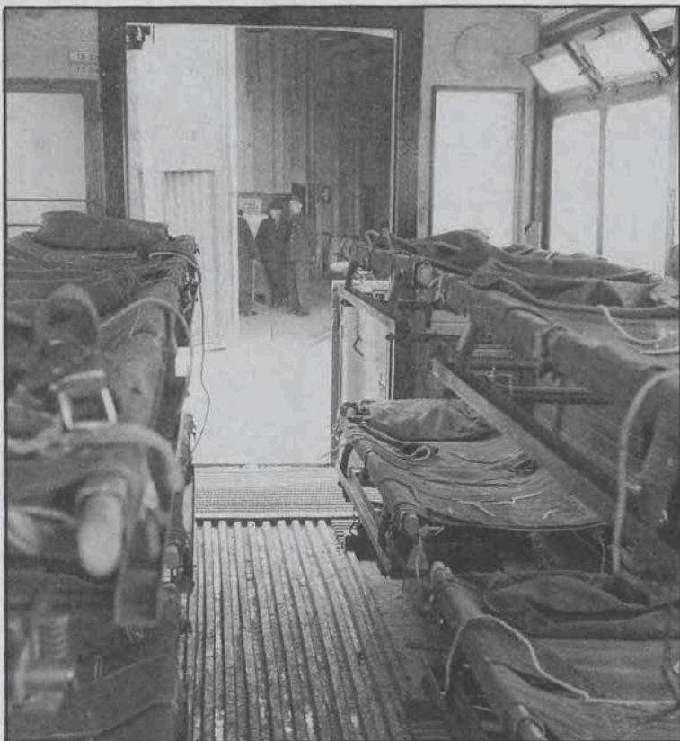
Wnętrze wagonu sanitarnego nr bocz. 561. Widać sposób zamocowania w nim noszy.
