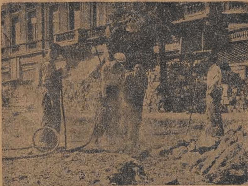
Prace przy budowie tunelu Warszawa — Praga trwała. Oto fragment robót na odcinku Nowy Świat — Bracka — usuwanie nawierzchni przy użyciu młotów pneumatycznych.
