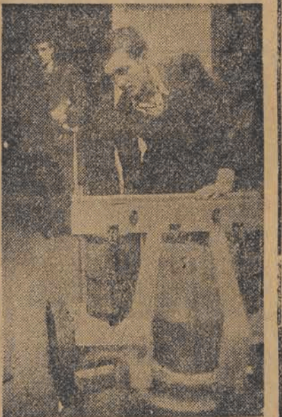
Tow. Wacław Przybyszewski monitor transformatorów wraz z całą grupą postanowił w przeciągu pół roku podnieść wykonanie baz akordowych do 200 procent.
