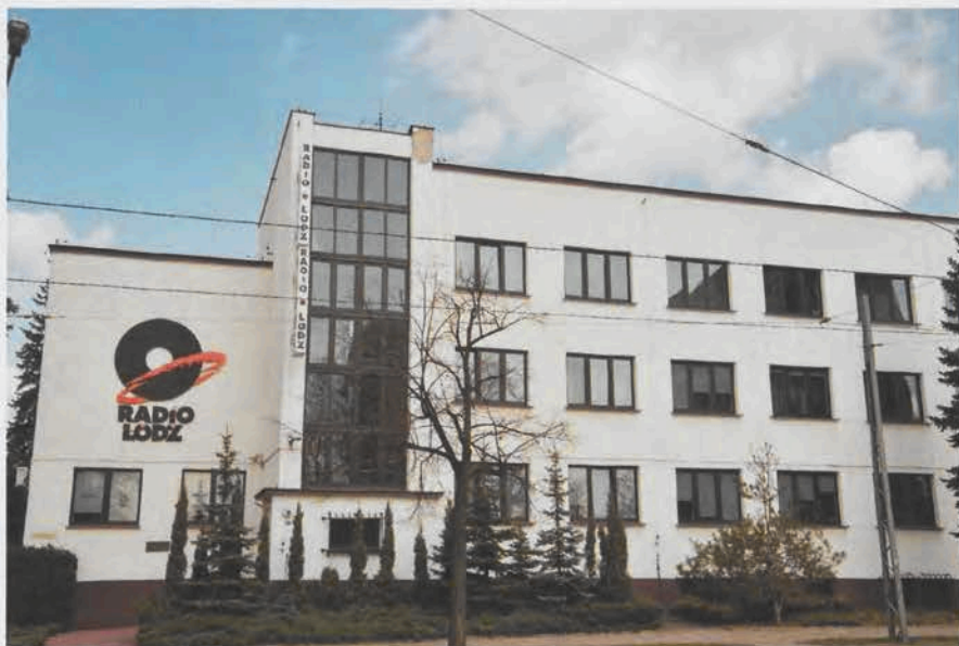
ul. Narutowicza 130, Rozgłośnia Radia Łódź
