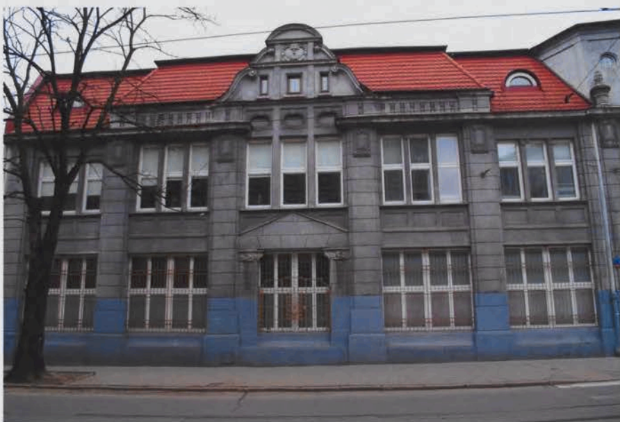
Budynek „Caritas”. Widok z ulicy Kopernika
